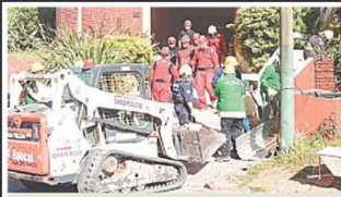
UN GRUPO DE RESCATISTAS LLEGAN AL LUGAR CON EQUIPOS PARA REMOVER LOS ESCOMBROS
